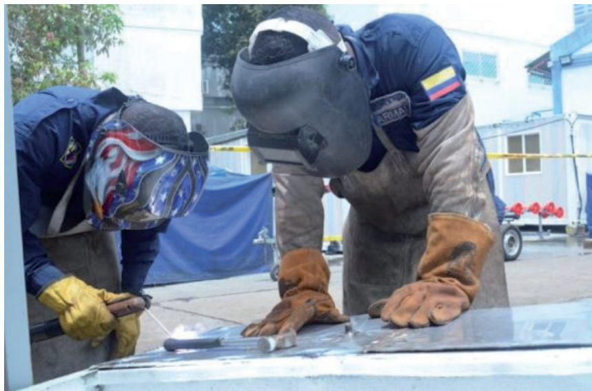
Fig. 5. Top lid welding.
